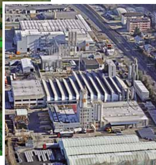
Noua fabrica de poliuretan (Kapaflex) în Düringen (Elveția)
