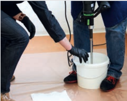
Mixare manuală a Sikasil GS 687 cu mixer în formă de con.
