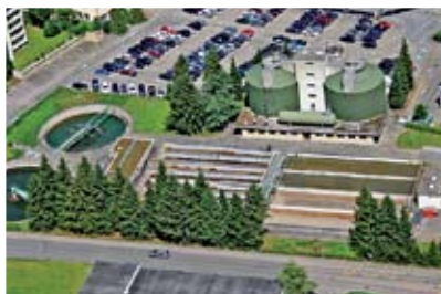
Stații de tratare a apei
