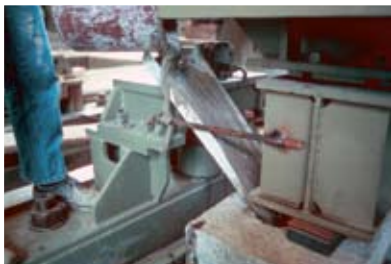
Subturnarea fundațiilor de mașini
