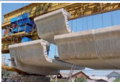
Industria producătoare de prefabricate
