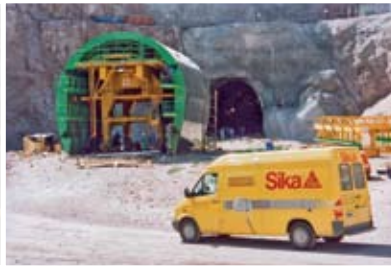
Suport în șantier
