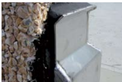
Rosturi de închidere la acoperișuri
