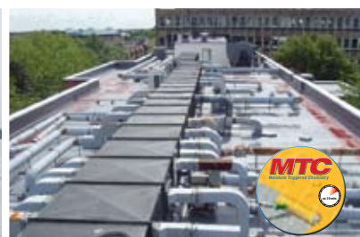
Reparația acoperișurilor cu membrane lichide
