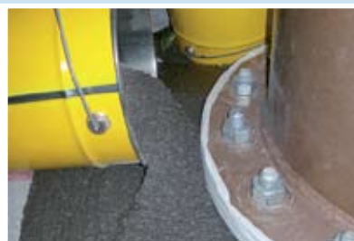
Subturnări pe bază de rășini epoxidice
