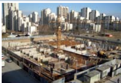
Producția de beton în șantier
