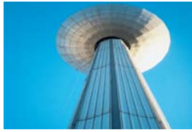
Rezervoare de apă
