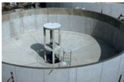
Rosturi în stații de epurare
