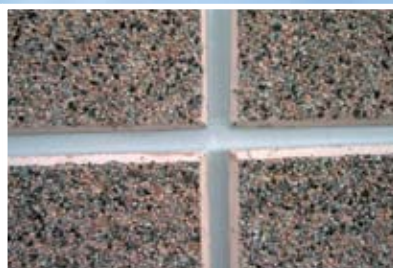
Rosturi la elementele prefabricate
