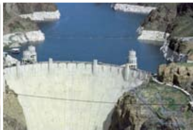
Lipiri structurale la baraje
