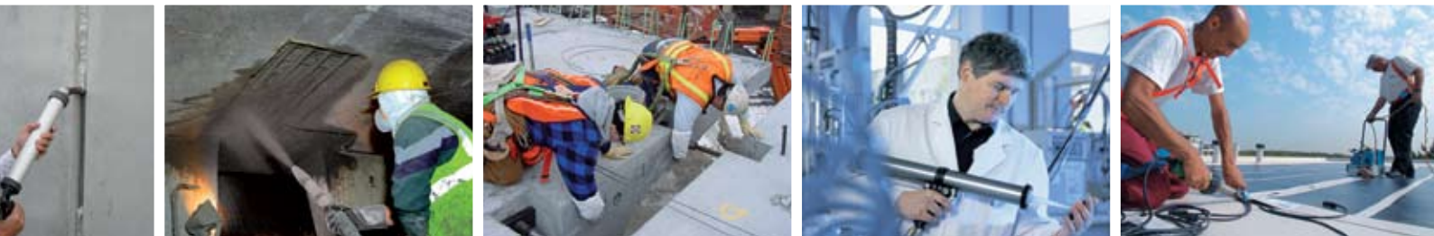
Reparația și protecția structurilor din beton
