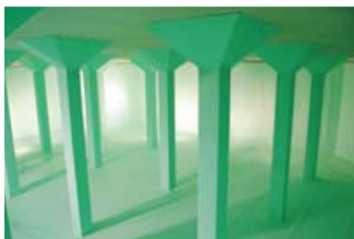
Impermeabilizarea rezervoarelor de apă potabilă
